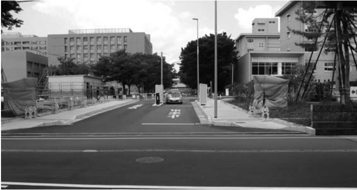
写真1 市道側から見た新正門（門柱にはシートがかけられている）、右端に金沢医学館第一期卒業生の群像が見える
