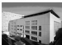
救急部入口からみた新中央診療棟
