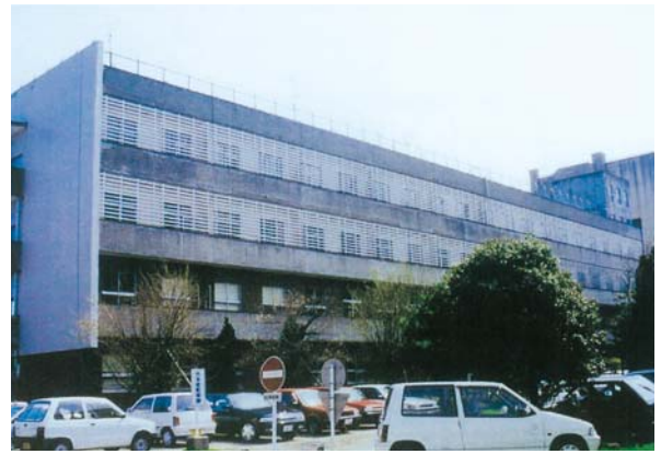
図4 1968年12月新築された第5病棟
