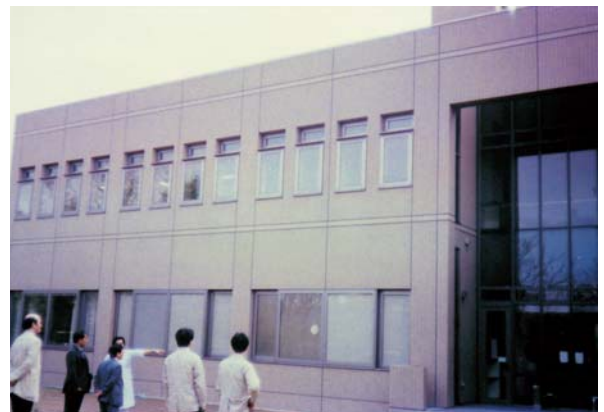
図8 2000年12月竣工なった北病棟
