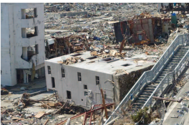
写真 1: 宮城県女川町における四階建コンクリート建物の転倒
